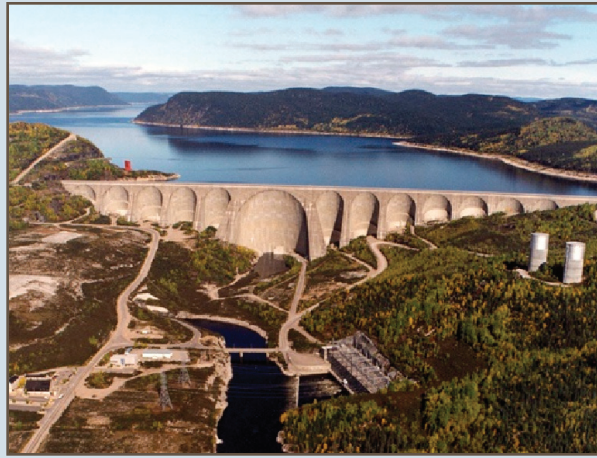
Barrage de la Manic 5 (Hydro-Québec)
